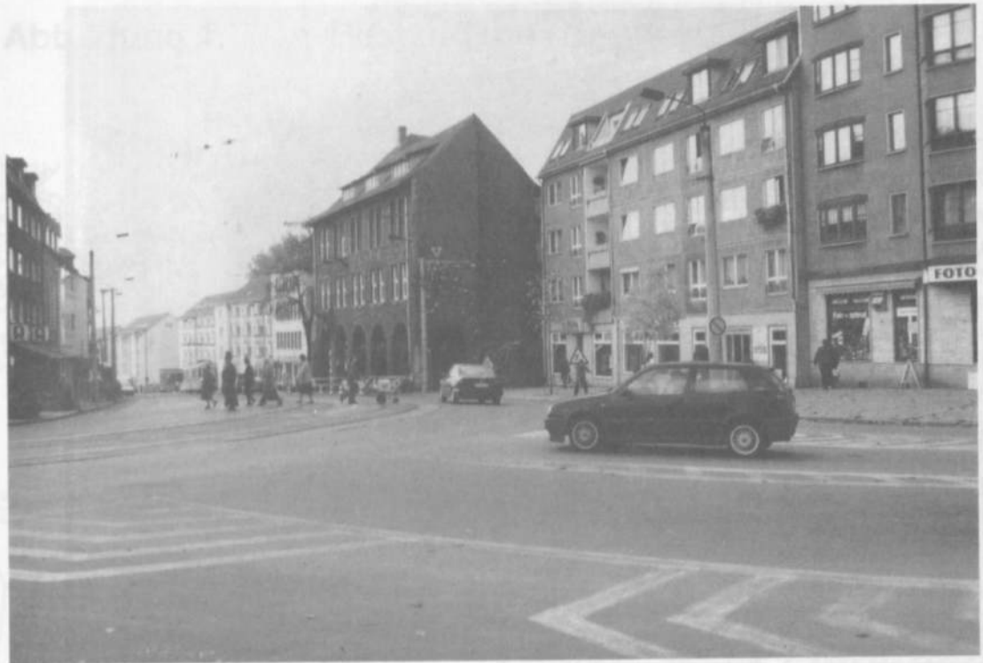
Foto 3: Blick vom Kornmarkt Richtung Süden in die Rautenstraße und auf das Stadthaus
