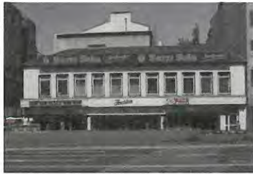
Eckgebäude Große Straße
