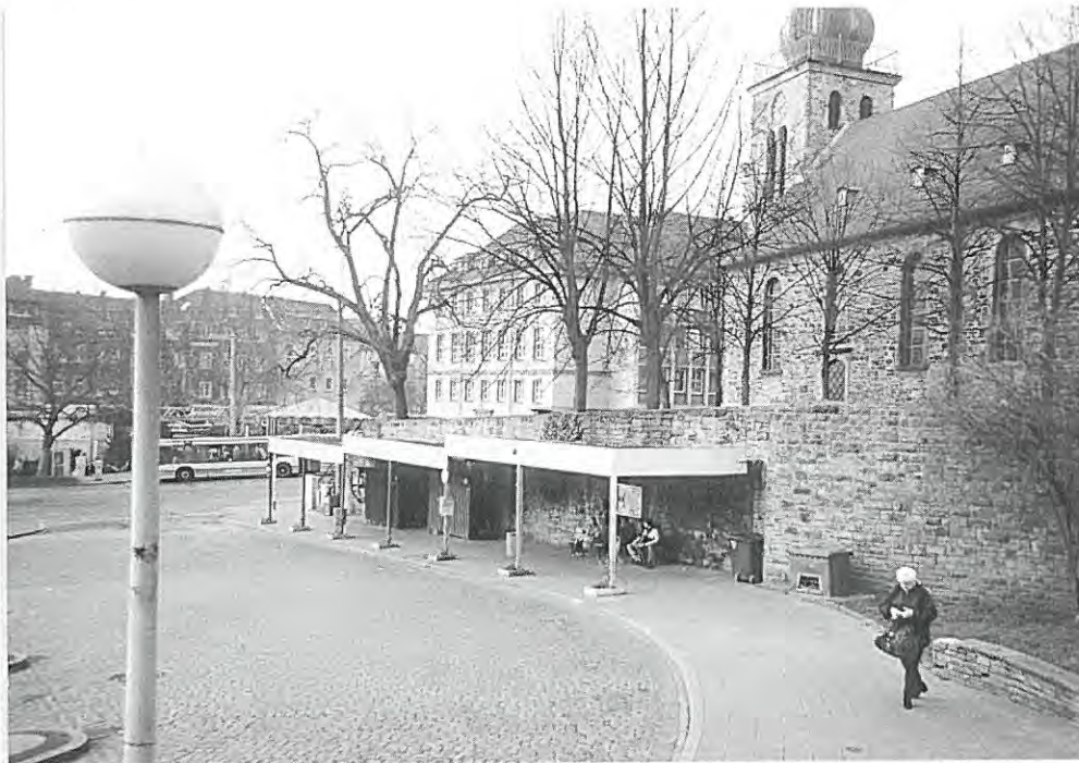
Johannismauer mit Toilettenanlage und Wartebereich
