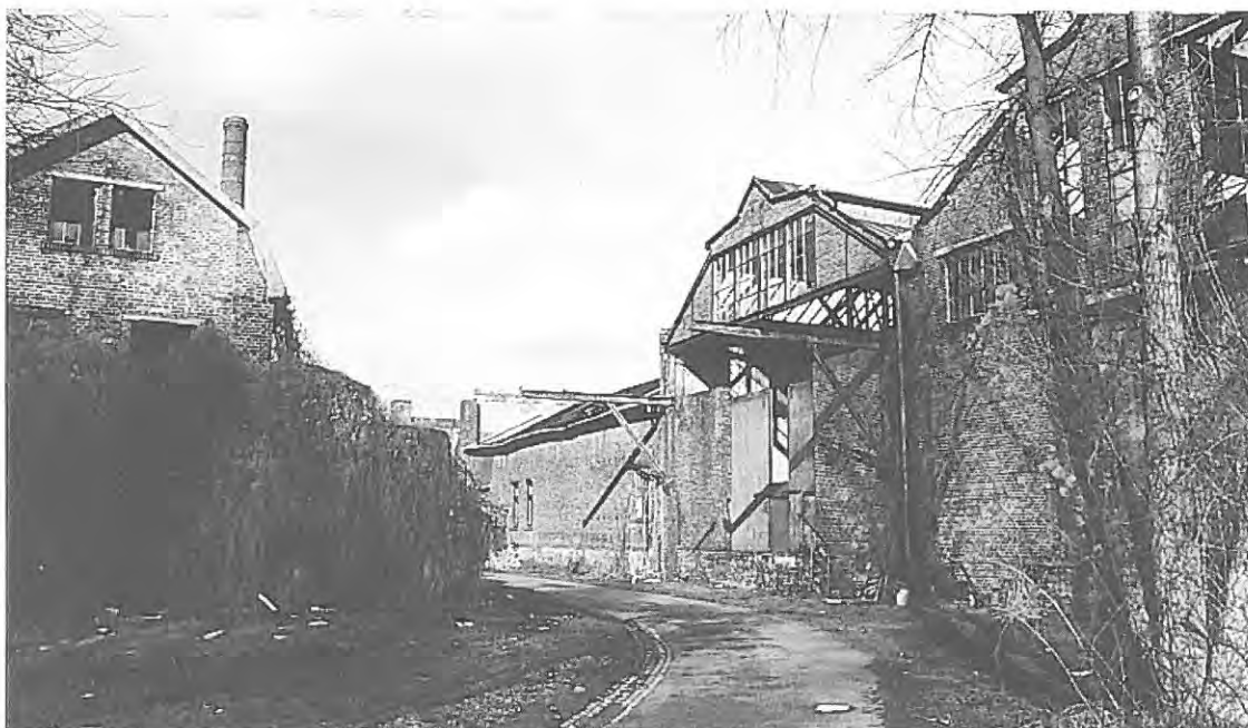
Gempt-Gelände vom Eingang „Auf der Laar
